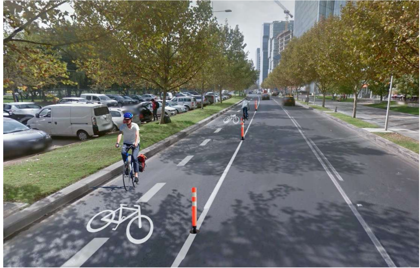
Demarcar con señales de ciclovías y delineadores cada 8 metros. (Ej. Av. Pdte. Riesco)
