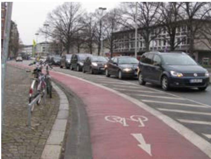
Señalización horizontal para demarcación de carril para bicicletas. Fuente: Rafael Valladares (2017)
